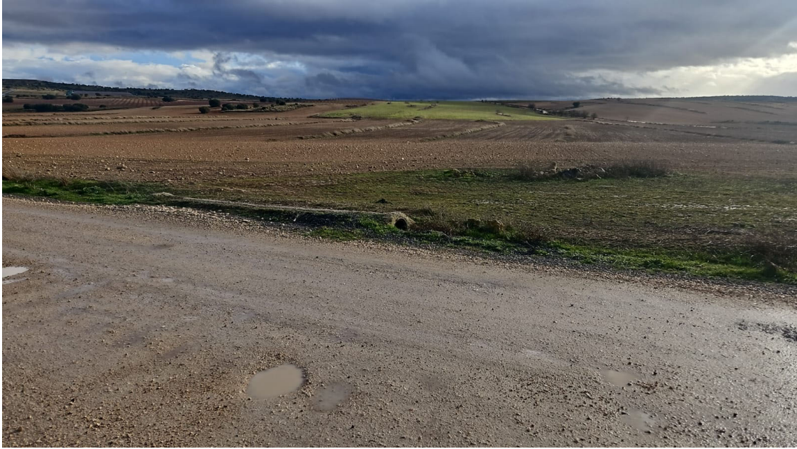
FOTOGRAFIA FRONTAL PASO DE TUBOS, ACCESO A LA PARCELA CATASTRAL.
